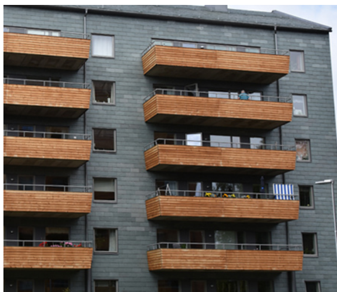
Skövdebostäder är ett av flera kommunala bostadsbolag som börjat klä fasader med naturstenen skiffer.
