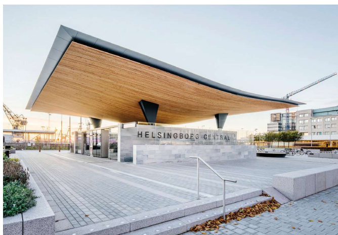
Helsingborgs Centrals södra entré är nominerad till Världens byggnad av World Architecture Festival. Byggnaden är ritad av Tengbom arkitektbyrå med skiffer från Nordskiffer. Bild: Tengbom / Felix Gerlach
