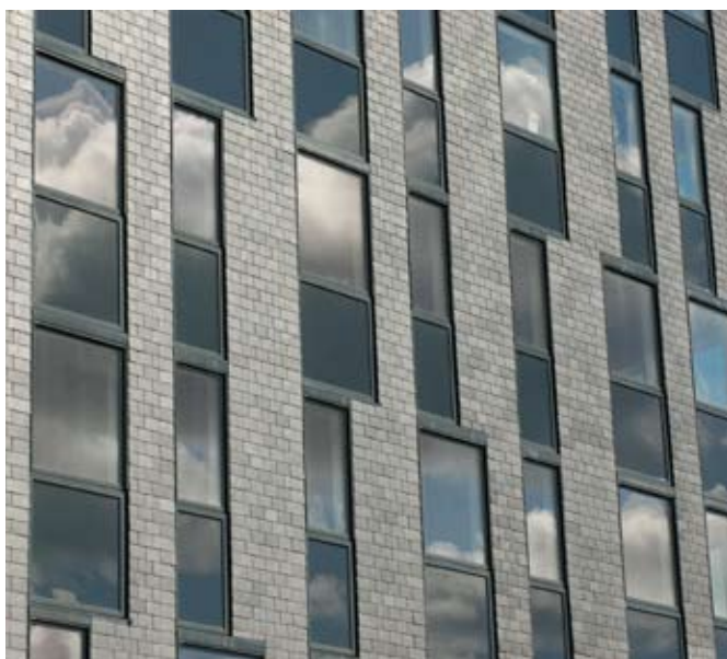
World Trade Center i Växjö, beklätt med takskiffer på fasad. Ett material som ökar markant som fasadbeklädnad. Foto: Nordskiffer AB
